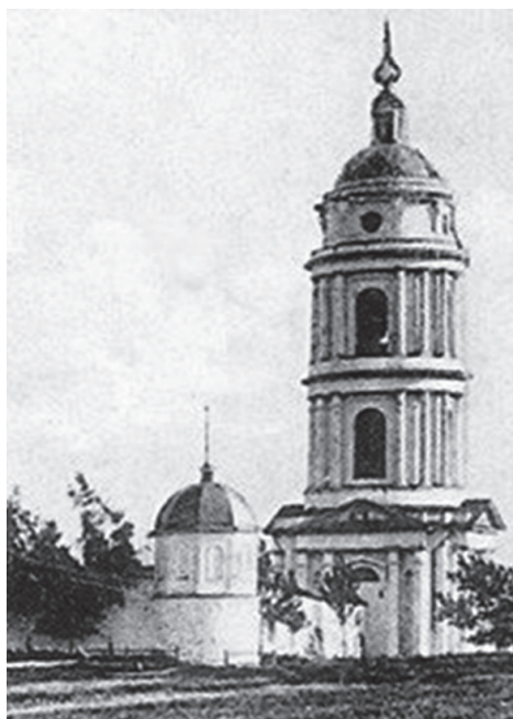
Фото 3. Состояние колокольни в 20-е г. XX в. до разрушения в 1928 г.
